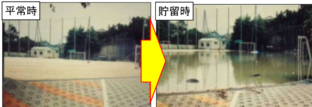
流出抑制対策（校庭を調節池として利用） 【利根川水系】
