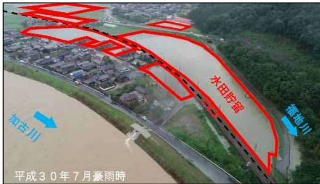
平成30年7月豪雨時 水田の雨水貯留機能の強化(田んぼダム)事業 【加古川水系】
