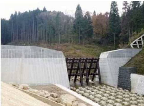
砂防関係施設整備
