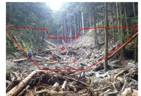
下流域への土砂・倒木の流出を防止する治山ダムを整備
